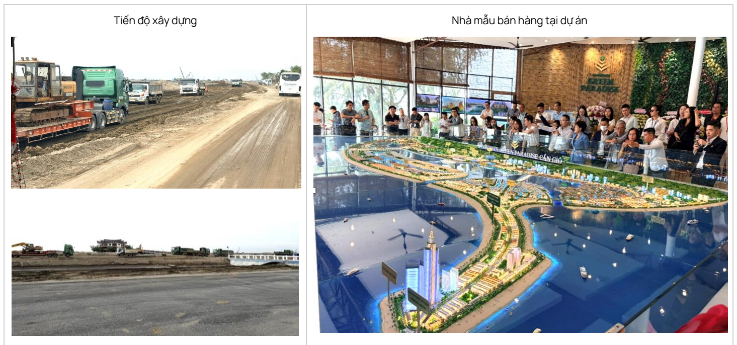
Hình 19: Hình ảnh thực tế tại dự án Vinhomes Green Paradise
