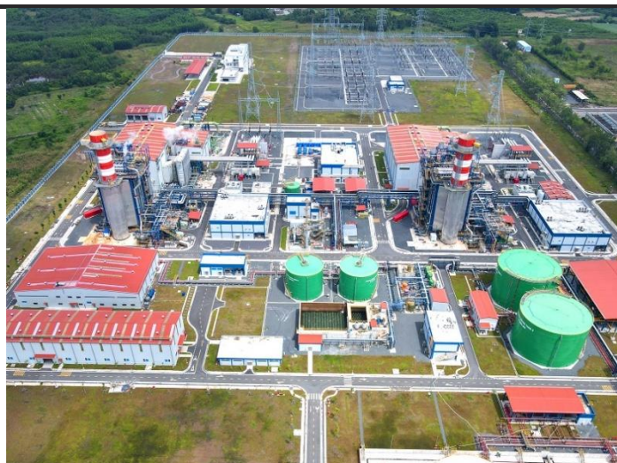
Hình 1: Nhà máy điện khí LNG NT3&4
