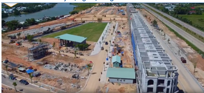
Hình 1: Dự án Bắc Hà Thanh Hoàn thành 95% xây dựng hạ tầng
