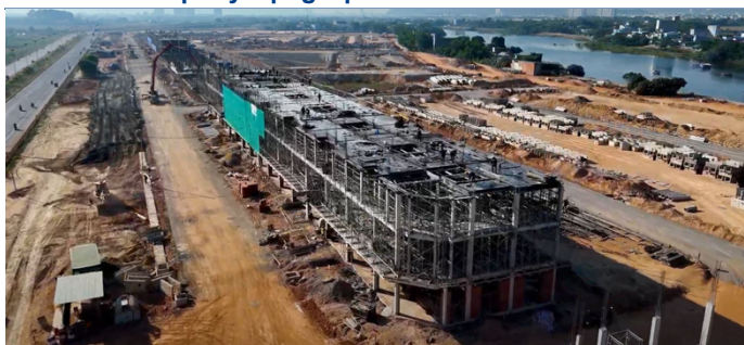
Hình 2: Tiến độ xây dựng dự án Bắc Hà Thanh
