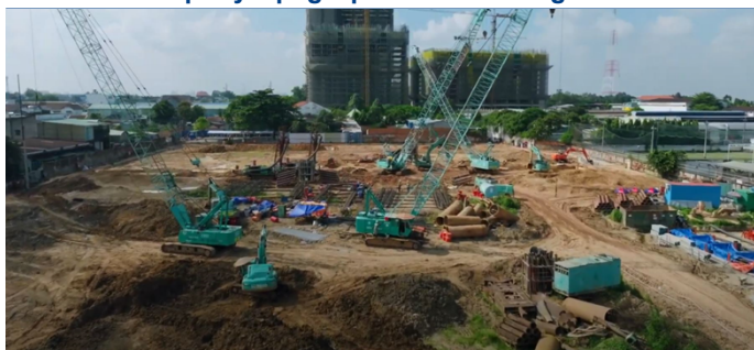
Hình 3: Tiến độ xây dựng dự án Bình Dương Tower
