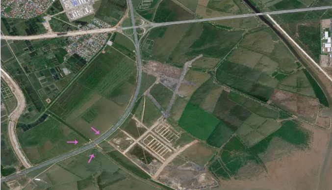
Hình 2: Tốc độ thi công của KĐT Trảng Cát là tương đối chậm
