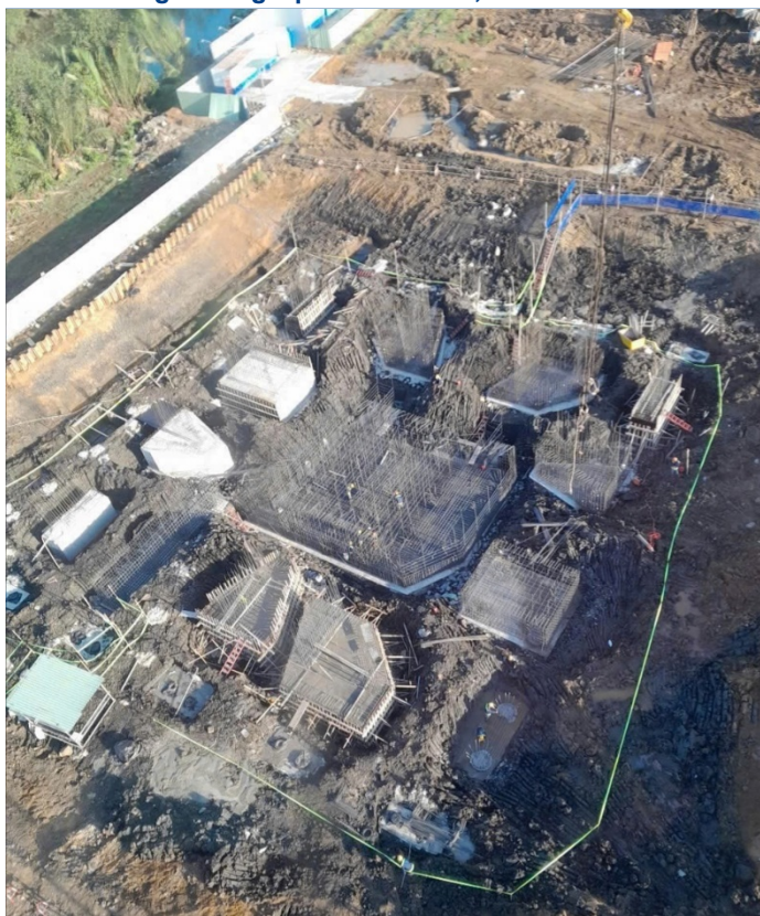
Hình 2: Công trường dự án The Prive, DXG
