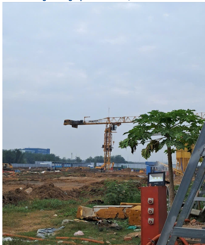
Hình 3: Công trường dự án The Prive, DXG
