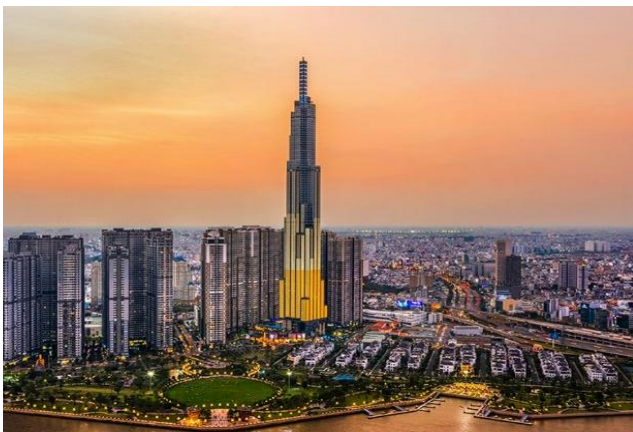
Dự án tòa nhà The Landmark 81
